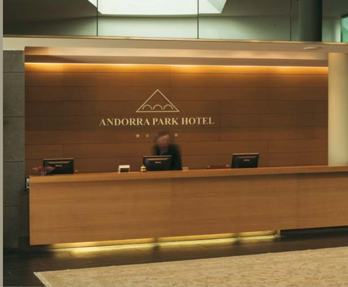
En la recepción se realizó un mostrador continuo con iluminación inferior y panelado posterior, integrando ordenadores, impresoras y escritorios. Reception area panelling with concealed perimeter lighting feature - the reception desk fully integrates and conceals all computers and printers.
