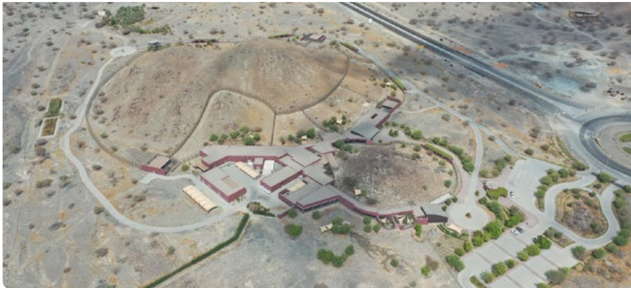
أعمال توريد وتركيب سياج شبكي خاص بمحمية الحفية بكلباء
